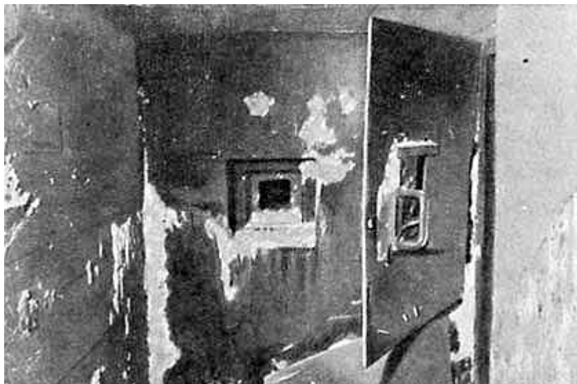
Стальные двери и амбразуры, защищающие вход в дот (стр. 185)
