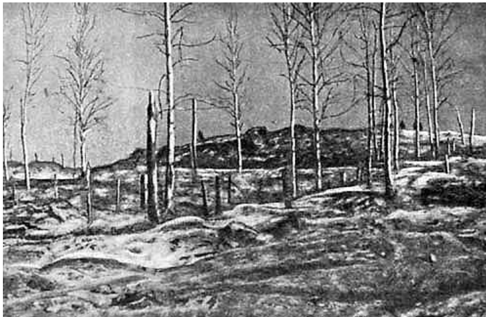
Общий вид дота № 45 со стороны подступов. Перед дотом видны остатки проволочных заграждений
