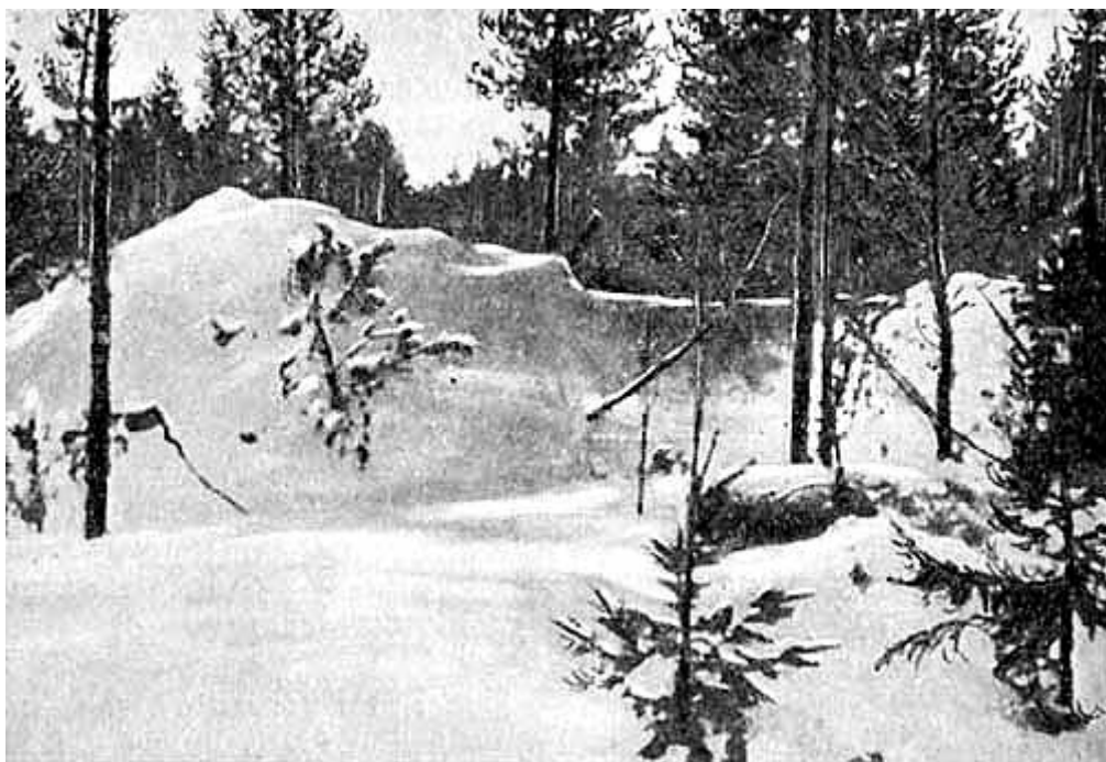
Замаскированные дзоты на высоте «Груша». Маскировкой служила металлическая сетка, покрытая вязким волокном
