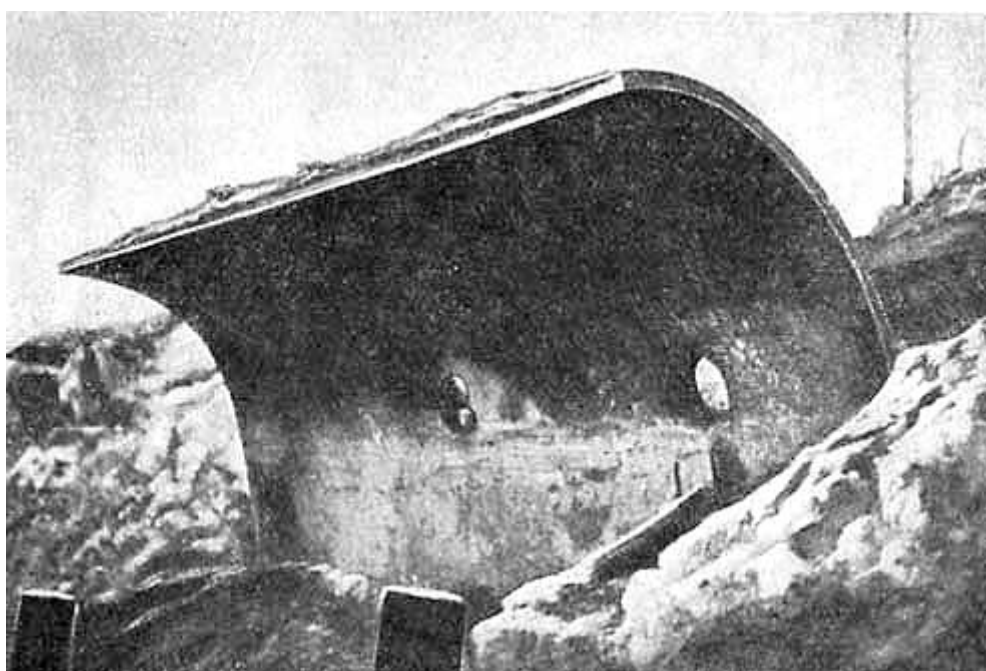
Броневого щита с козырьком
