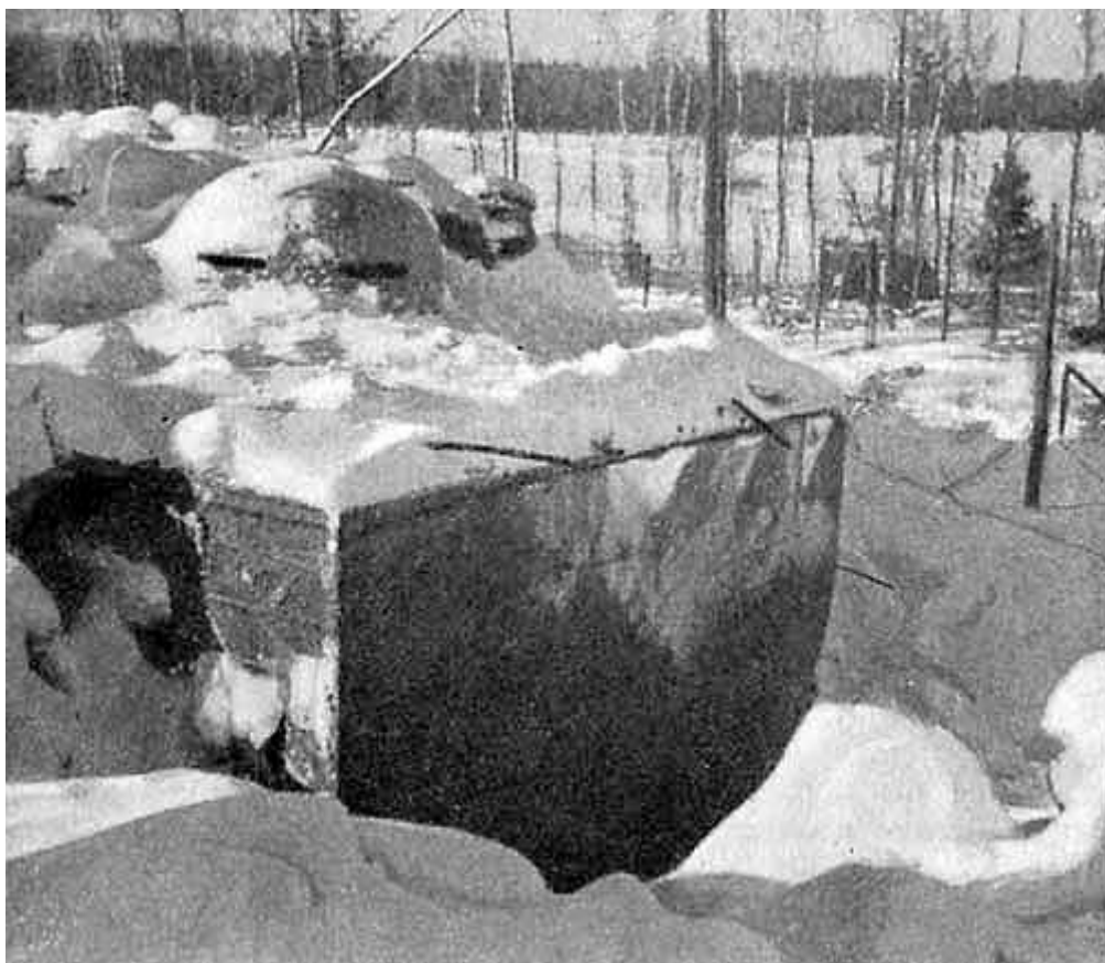
Наблюдательный броневой колпак дота (Вяйсяненский укрепленный узел) (стр. 243)
