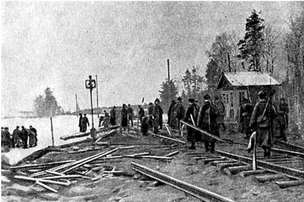
Восстановление железнодорожных путей, взорванных белофиннами при отступлении
