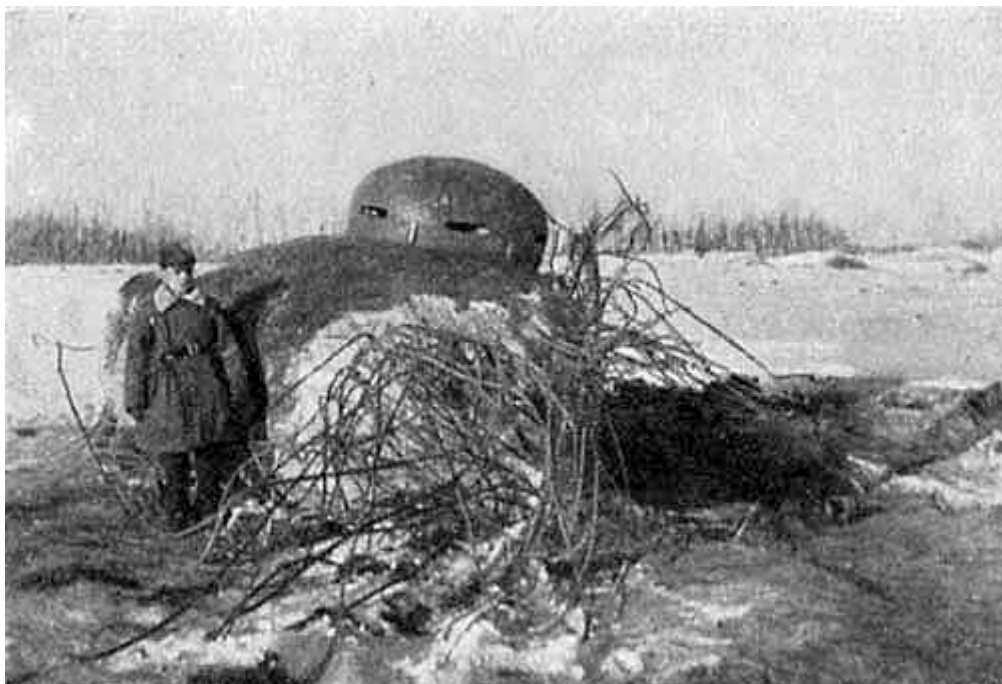
Бронекупол дота, отброшенный взрывом на 70 метров (стр. 151)
