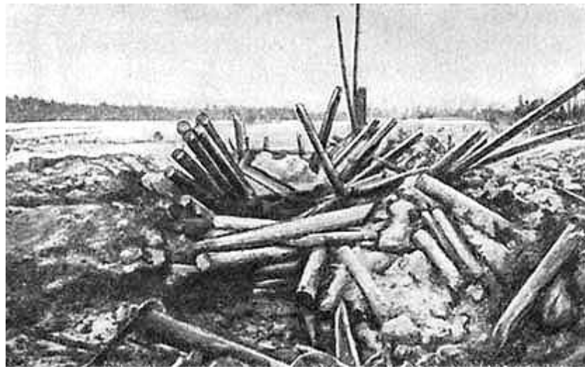
Дзот, разрушенный 152-миллиметровым снарядом
