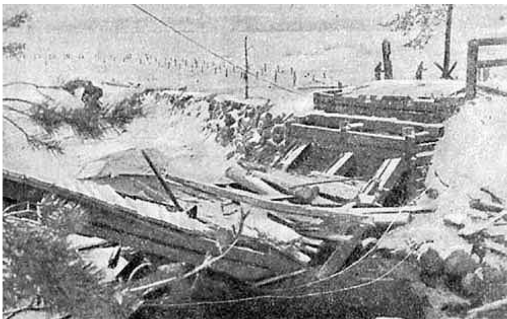
Мост через противотанковый ров, наполненный водой. Разрушен белофиннами при отступлении
