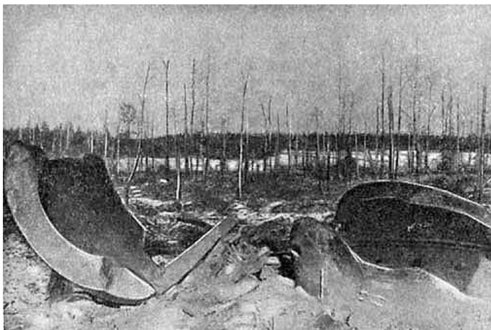
Разбитый артиллерией бронекупол одного из дотов
